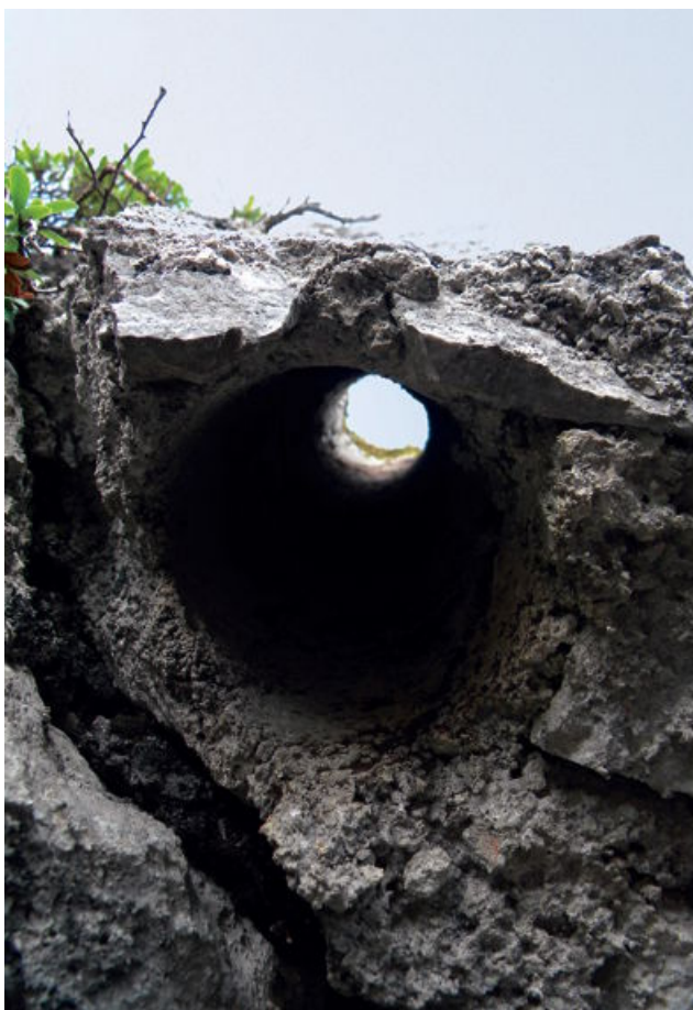
Gladko ulita cev jaška v oboku zidu na Jamarskem vrhu
